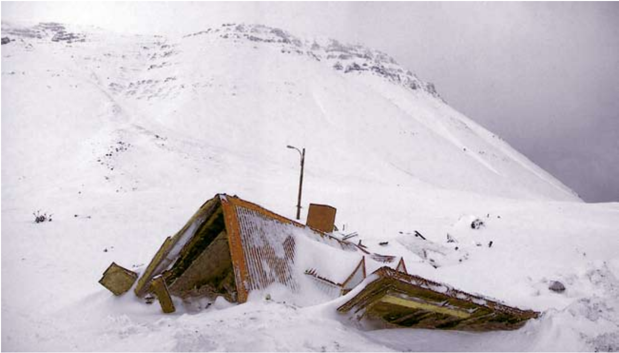
Rústir íbúðarhúss í Hnífsdal eftir snjóflóð árið 2005.
